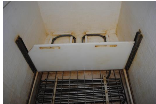
(b) : Serpentins de refroidissement de l'eau
