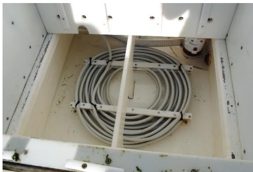
(a) : Serpentin de refroidissement de l'eau
